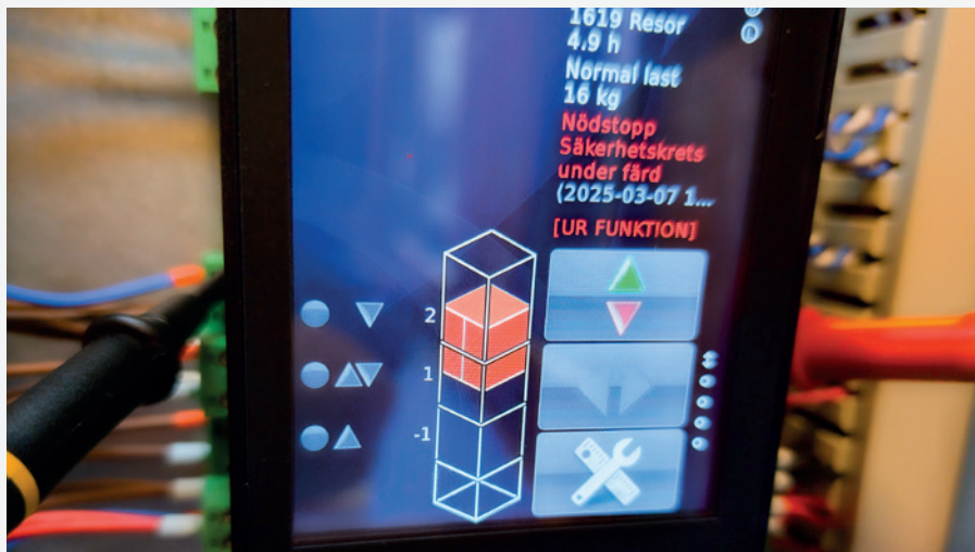
HBU har satt opp et nytt kurs som tar for seg moderne heiser.
